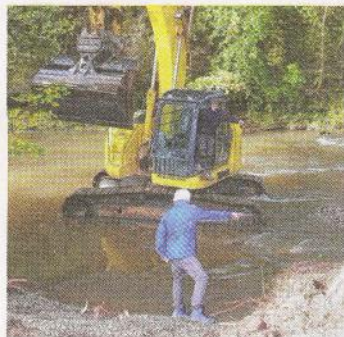
Der Bagger wird durch den Kocher dirigiert.
